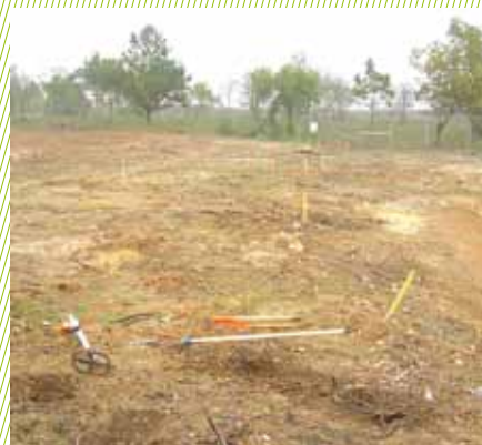
Picage des cibles métalliques
